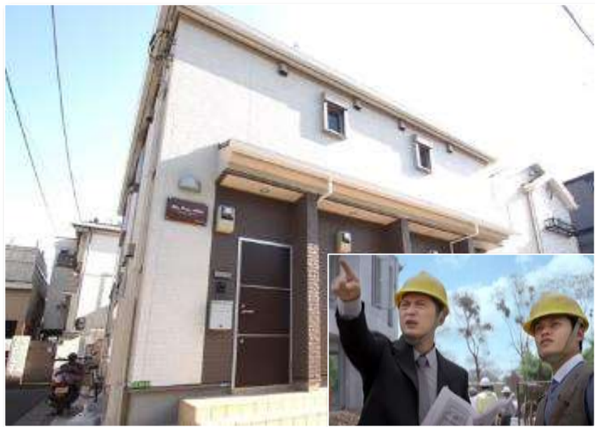
アパート施工風景
