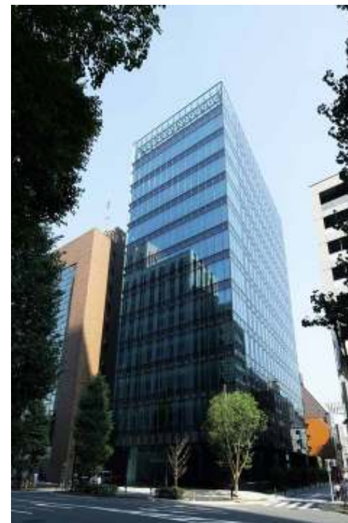
Jトラスト株式会社 本社ビル(東京都港区)
